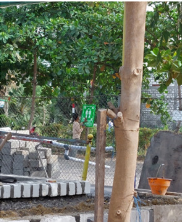
Gambar 6. Pemasangan Titik Kumpul
