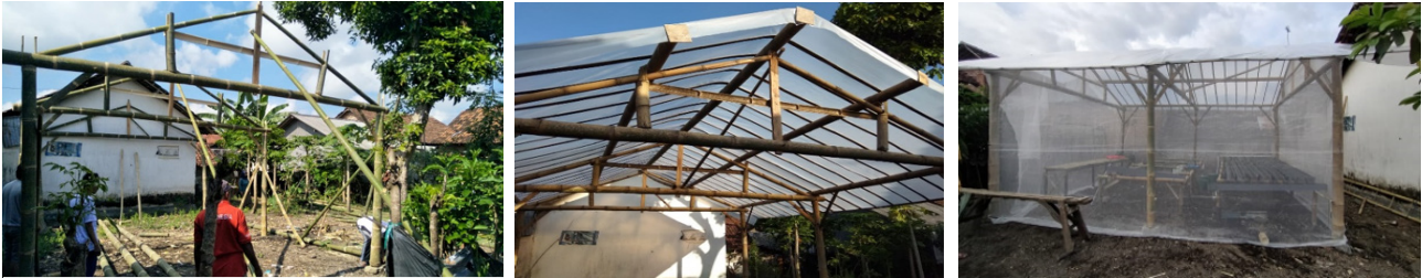
Gambar 2. Pembuatan Green House yang Meliputi Pembuatan Rangka, Pemasangan Plastik UV dan Insect Net
