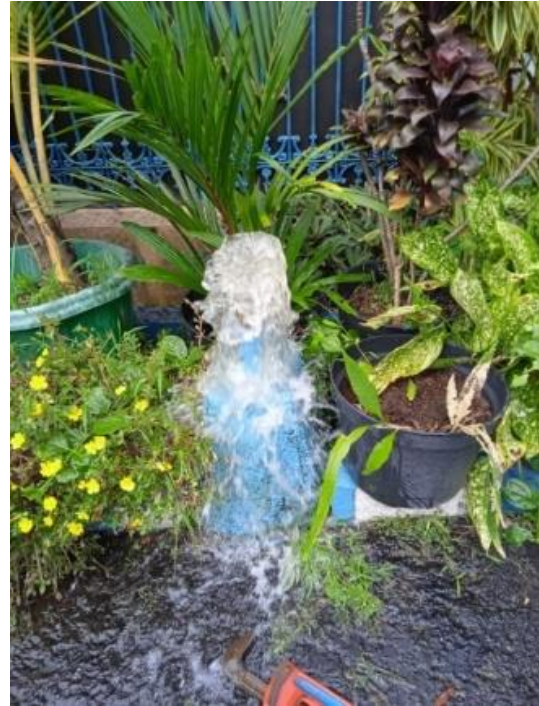
Gambar 9. Flushing menggunakan Bran Kran (BR)
