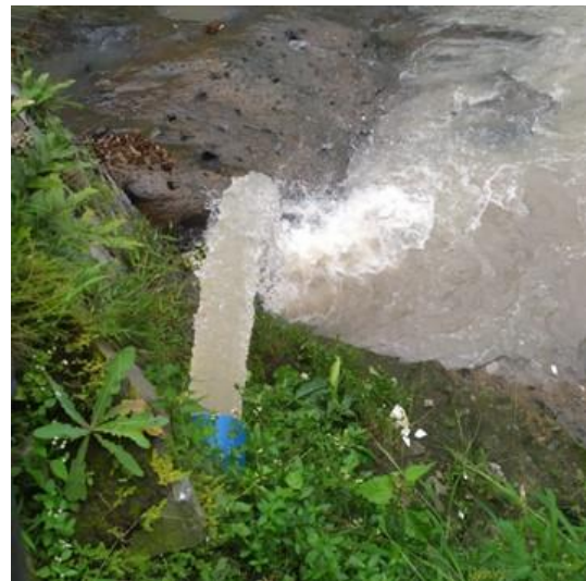
Gambar 10. Flushing menggunakan Blow Off (BO)
