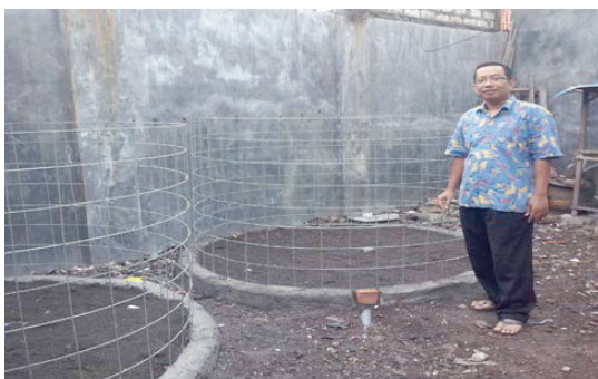
Gambar 2. Pembuatan Konstruksi Kolam
