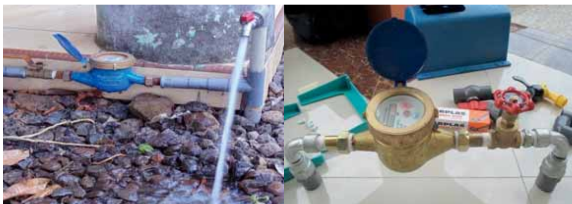
Gambar 3.4 Proses pemasangan sambungan rumah (2)
