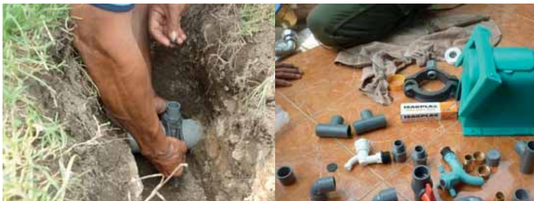
Gambar 3.4 Proses pemasangan sambungan rumah (1)
