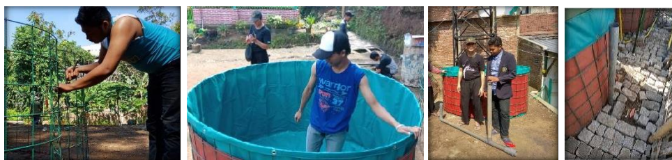
Gambar 3. Pemasangan Kolam Terpal Bulat (a) Menghubungkan ke dua ujung rangka besi wire mesh sehingga berbentuk lingkaran dan diikat dengan kabel ties. (b) Memasang Terpal (c) Menyiapkan pipa pembuangan (d) Pipa pembuangan
