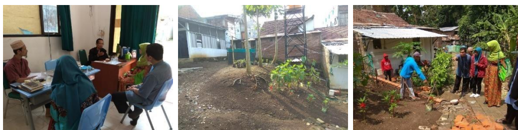
Gambar 1. Diskusi dengan pengasuh PPTI, Kondisi eksisting lahan baru kolam ikan PPTI , dan pemasangan dinding penahan dari batu bata,
