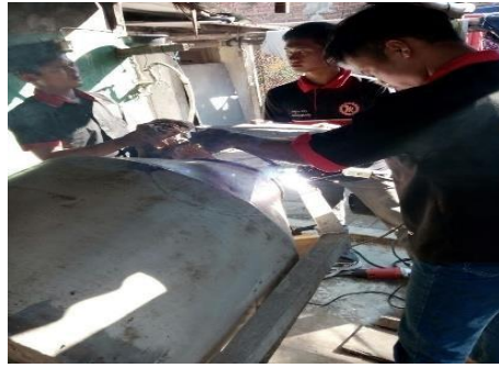
Gambar 4. Pemasangan Penyaring pada Penutup Alat Molen
