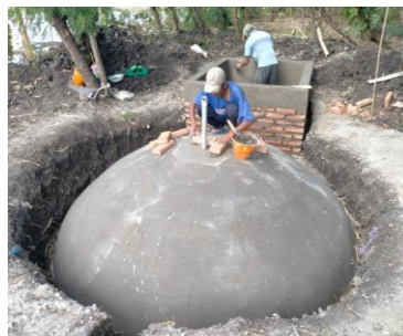
Gambar 10. Pemasangan Pipa Gas
