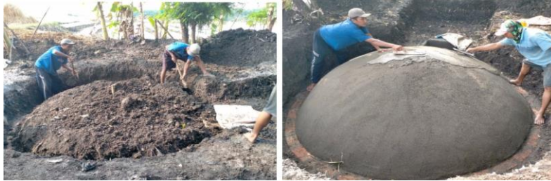
Gambar 9. Proses Bekisting dan Pengecoran Kubah
