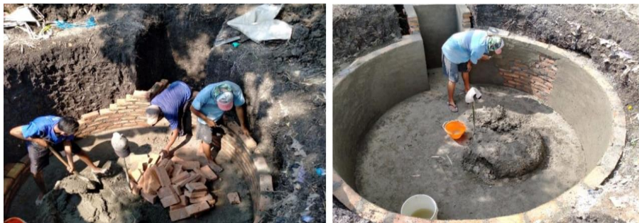
Gambar 8. Proses Pemasangan dan Pelicinan Dinding
