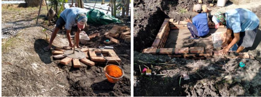
Gambar 12. Proses Pembangunan Inlet dan Outlet Sumber: Dokumentasi Pribadi
