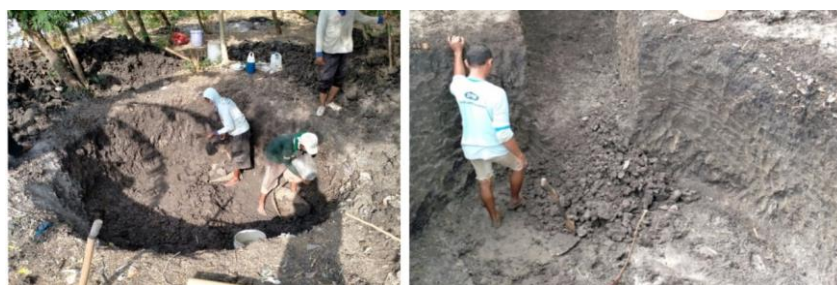
Gambar 6. Proses Penggalian Lubang Digester
