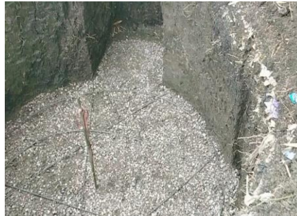
Gambar 7. Proses Pengecoran Lantai
