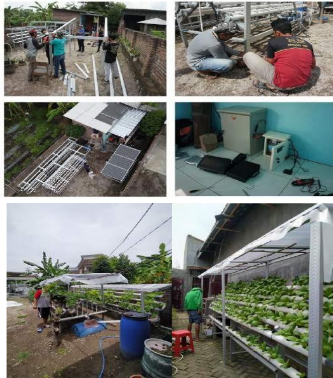
Gambar 2. Pengembangan rangka aluminium untuk pemasangan atap dan modul surya.
