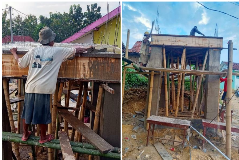
Gambar 8. Pembangunan pondasi untuk tandon di Desa Pancor, Kecamatan Ketapang, Kabupaten Sampang Madura.
