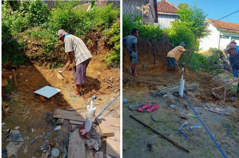
Gambar 7. Pembangunan Bor Sumur di Desa Pancor, Kecamatan Ketapang, Kabupaten Sampang Madura.
