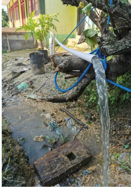
Gambar 9. Air sumur yang disalurkan dengan chasing pipa / pipa paralon.
