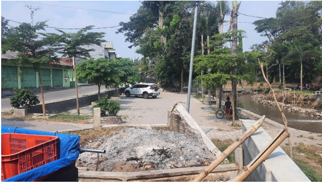
Gambar 1. Kondisi Sumber Bagindowati yang Sedang Direnovasi.
