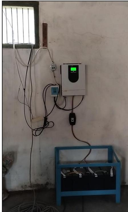
Gambar 3. *Peralatan pendukung sistem seperti baterai, inverter, dan pemutus arus (MCB) yang terpasang di dalam gedung.*
