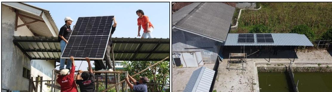
*Gambar 2. Proses pemasangan panel surya. (a) Tim pengabdian dibantu oleh anggota pokmas Maju Rukun memasang panel surya di atas atap. (b) Tata letak empat panel surya telah terpasang.*
