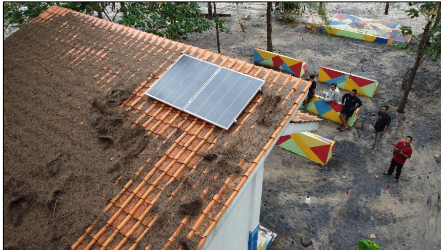
Gambar 8. Pemasangan PLTS hybrid di atap rumah.
