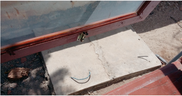
Gambar 11. Septic tank pembuangan limbah reagensia pewarnaan BTA. Di luar ruang mikroskopis, di lingkungan terbuka, tampak septic tank khusus untuk limbah larutan kimia reagensia pewarnaan, untuk standar keamanan kerja
